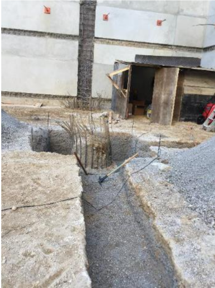
Excavación y elaboración de plantillas de contratrabes
